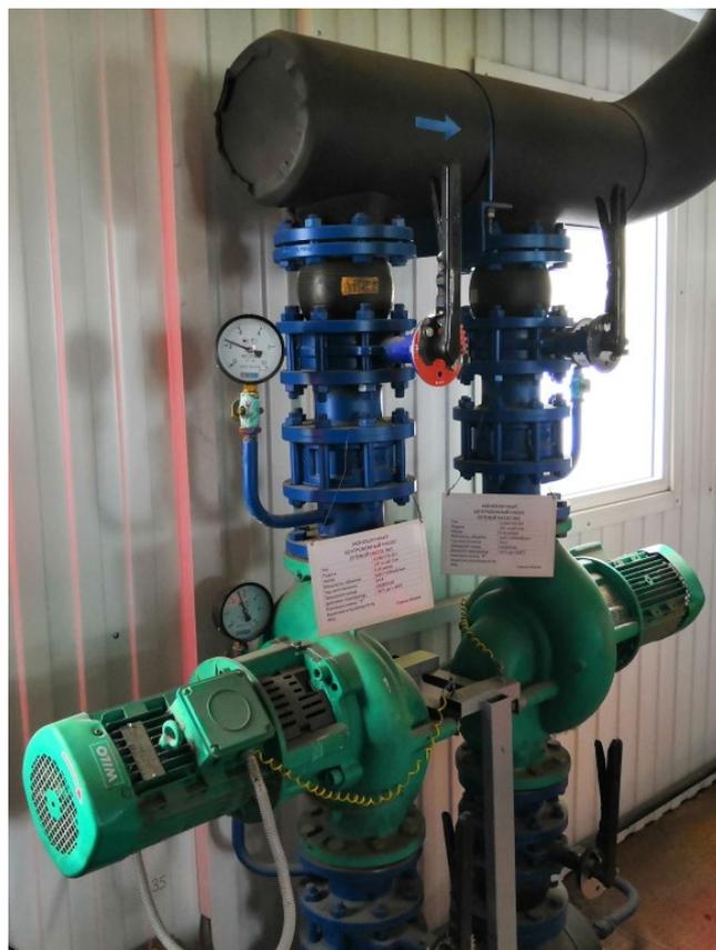
**Рис. 8.3 Насосное оборудование котельной**
