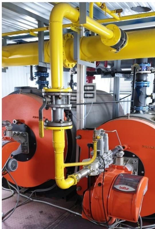
**Рис. 5.1 Общий вид котлов DUOTHERM 1500 и DUOTHERM 1000**
