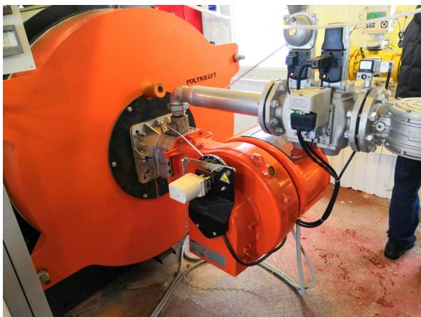
**Рис. 12.2 Общий вид горелки TBG 210P**
