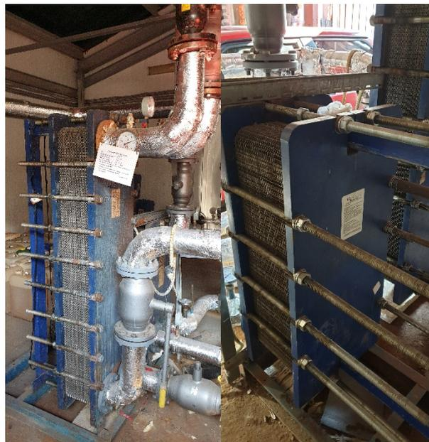
**Рис. 23.2** Пластинчатые теплообменники «Ридан» №1, №2
