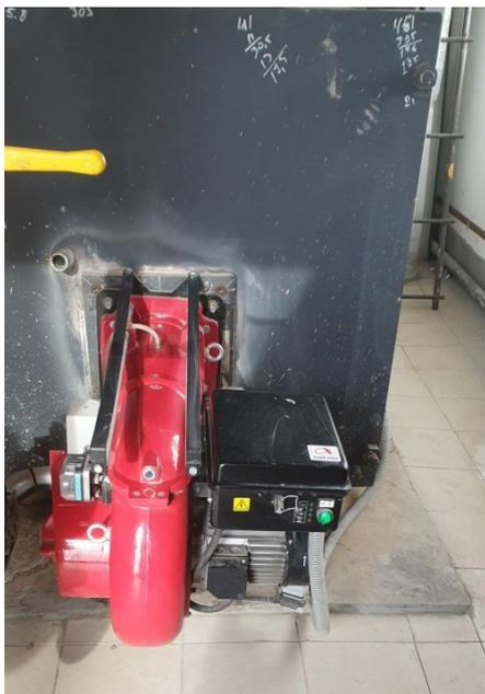
Рис. 2.3 Общий вид Горелки GAS P150/2CE системы отопления
