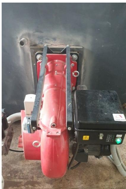
**Рис. 1.2 Общий вид Горелки GAS P150/2CE**
