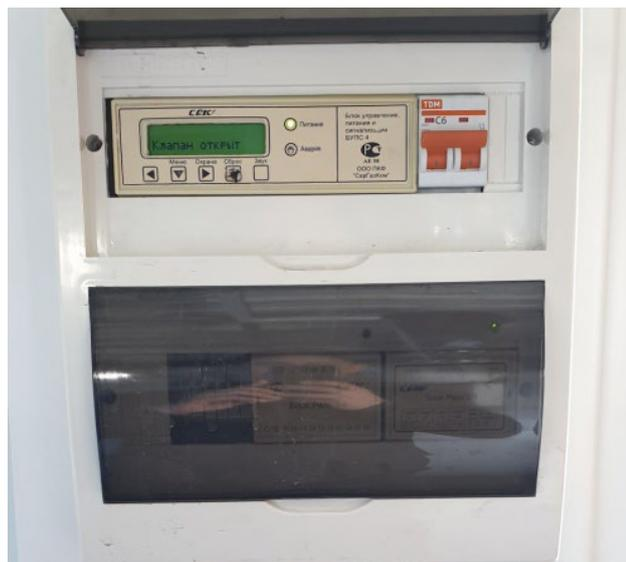
Рис. 15.5 Система защиты пожарной сигнализации
