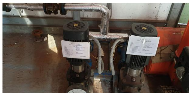
**Рис. 23.3** Моноблочный центробежный насос ГВС №1, №2
