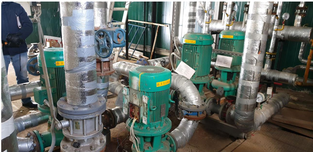
Рис. 22.4 Моноблочные центробежные насосы ГВС и отопления
