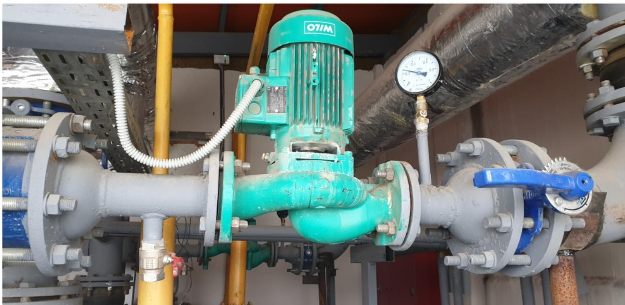
Рис. 2.5 Насосное оборудование котельной
