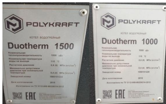
**Рис. 5.2 Шильдики котлов DUOTHERM 1500 и DUOTHERM 1000**
