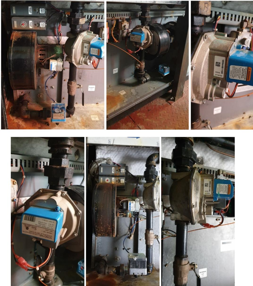
Рис. 6.3 Общий вид горелки ТВГ 210Р
