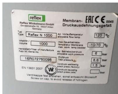
Рис. 6.4 Мембранный бак системы отопления
