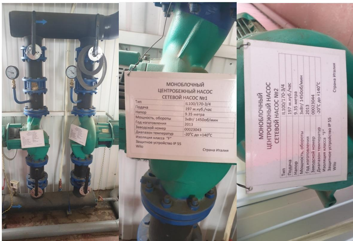
Рис. 3.5 Насосное оборудование котельной
