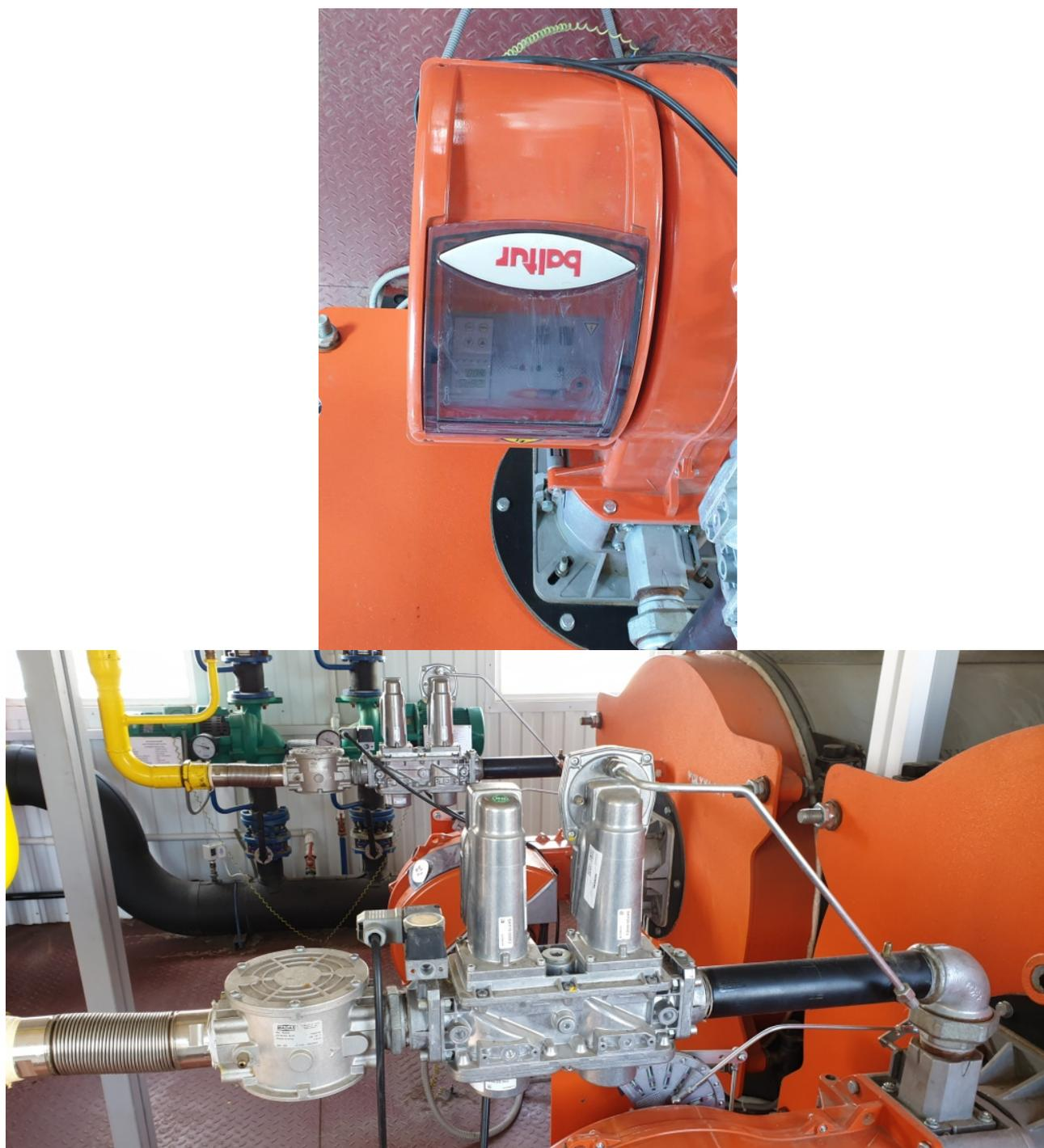
Рис. 16.2 Общий вид горелки TBG 120P
