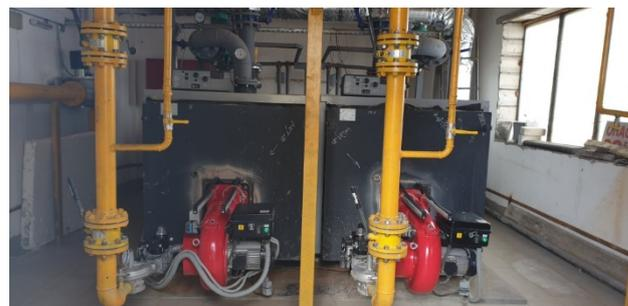
**Рис. 2.1** Общий вид котлов ALPHA E 1100 и ALPHA E 1320
