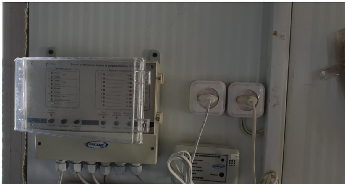
Рис. 19.5 Система защиты пожарной сигнализации
