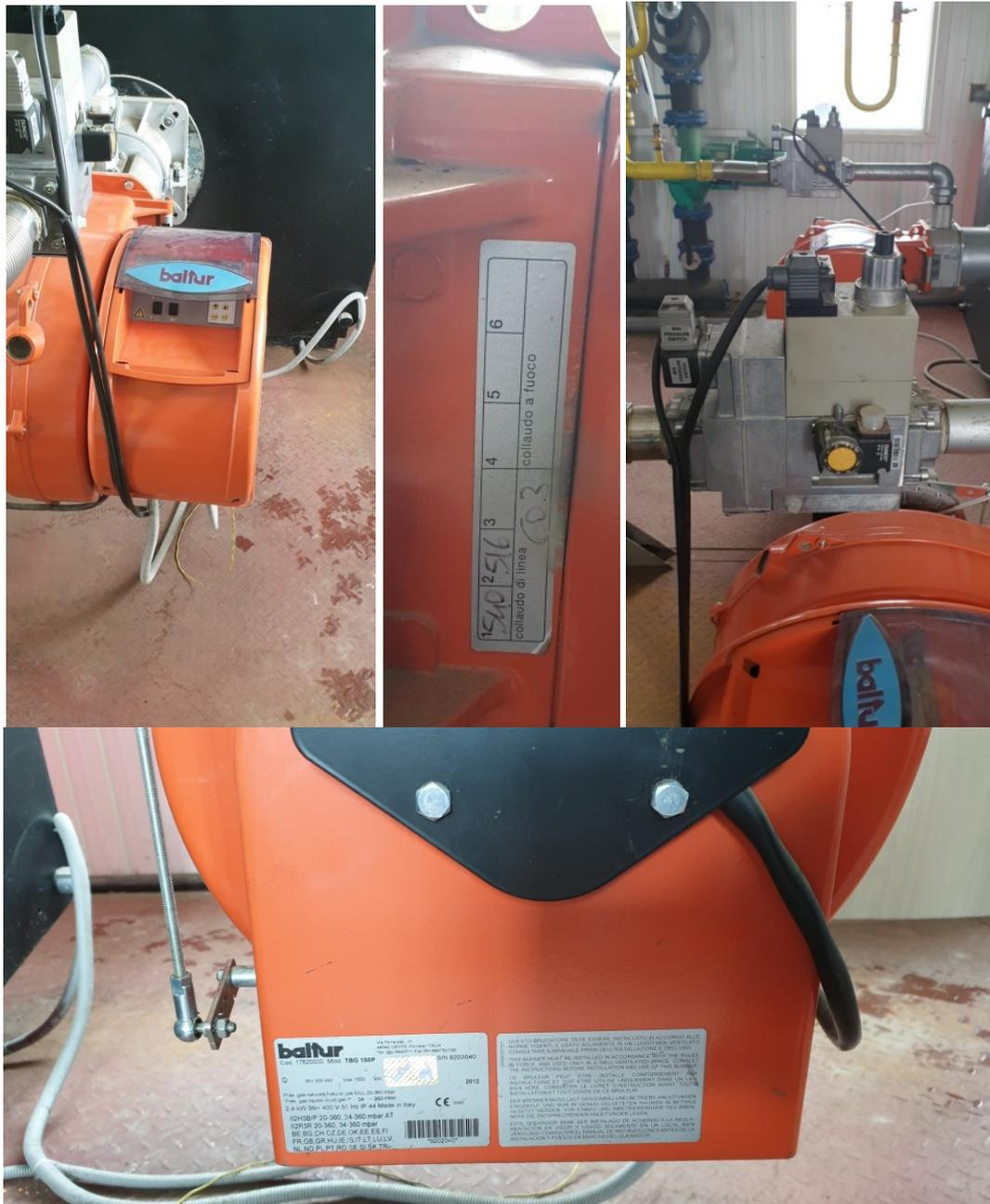
Рис. 3.3 Общий вид горелки TBG 150P
