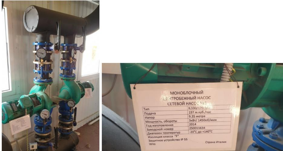
Рис. 18.4 Насосное оборудование котельной
