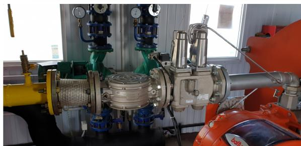
**Рис. 17.2 Общий вид горелки TBG 210P**
