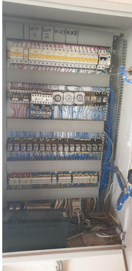
Рис. 2.7 Шкаф автоматики Котельной
