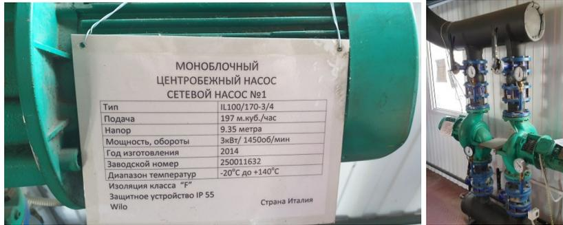
Рис. 17.3 Насосное оборудование котельной
