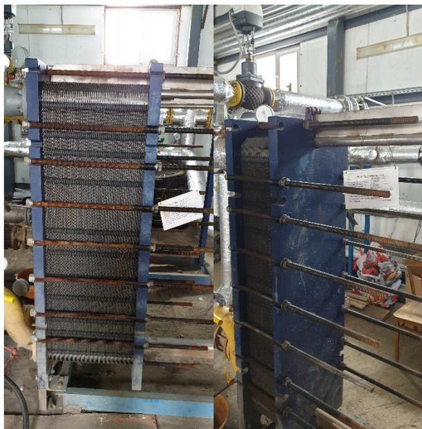
**Рис. 23.2** Пластинчатые теплообменники «Ридан» №1, №2
