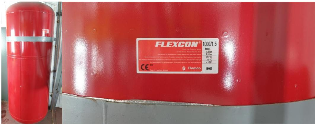
Рис. 5.4 Мембранный бак системы отопления
