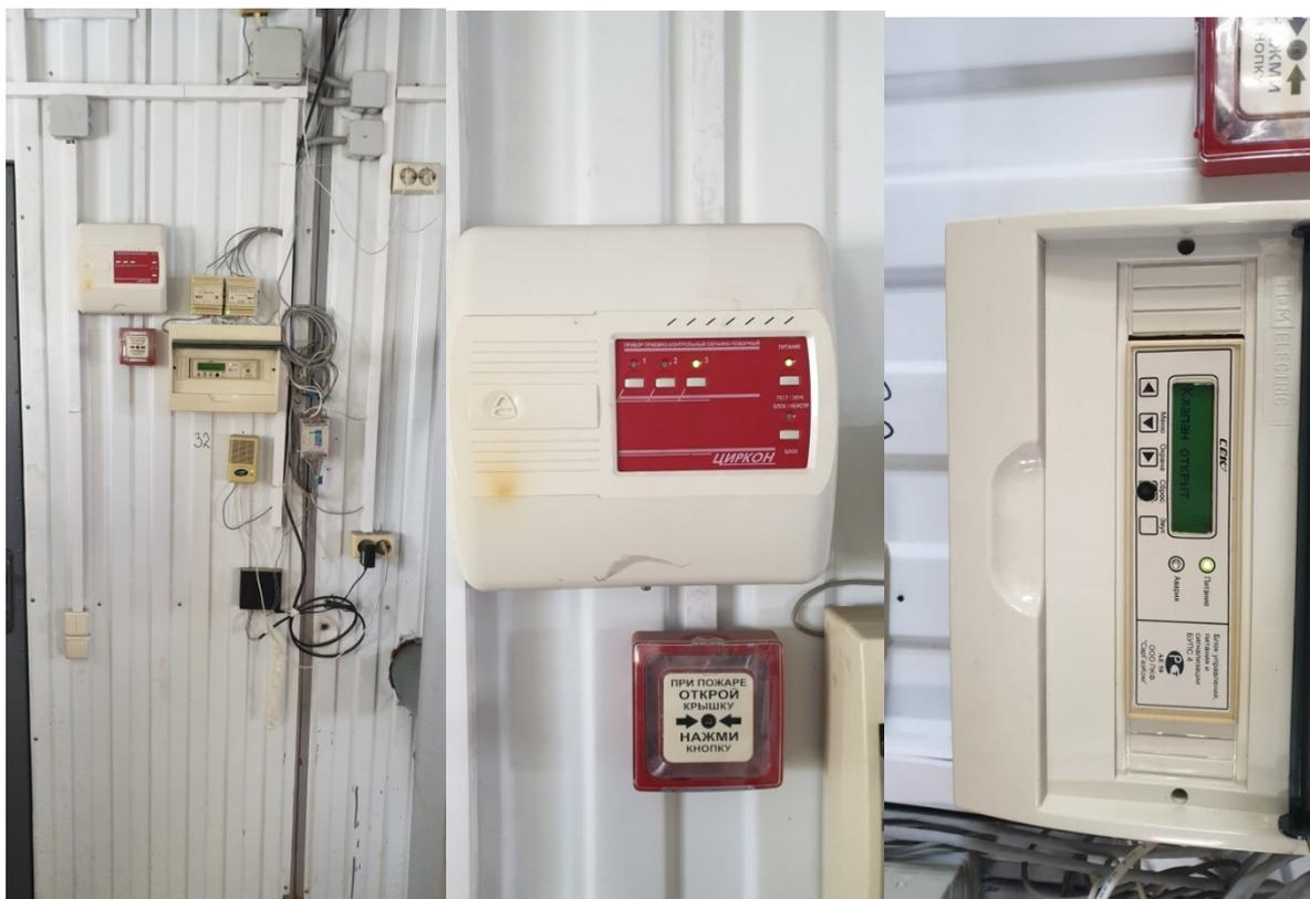
Рис. 3.9 Система защиты пожарной сигнализации
