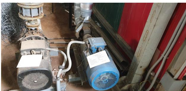
**Рис. 22.2** Моноблочный центробежный насос ХВС №1, №2
