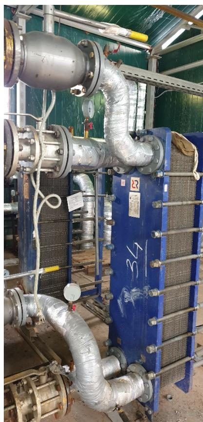
**Рис. 22.3** Пластинчатые теплообменники «Ридан» №1, №2
