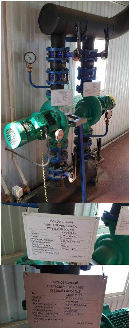
Рис. 13.3 Насосное оборудование котельной
