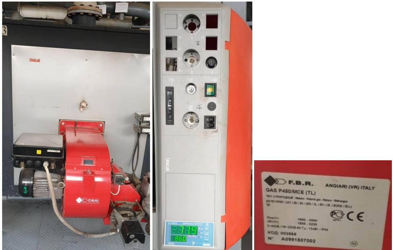
Рис. 20.4 Общий вид горелки GAS P450/MCE
