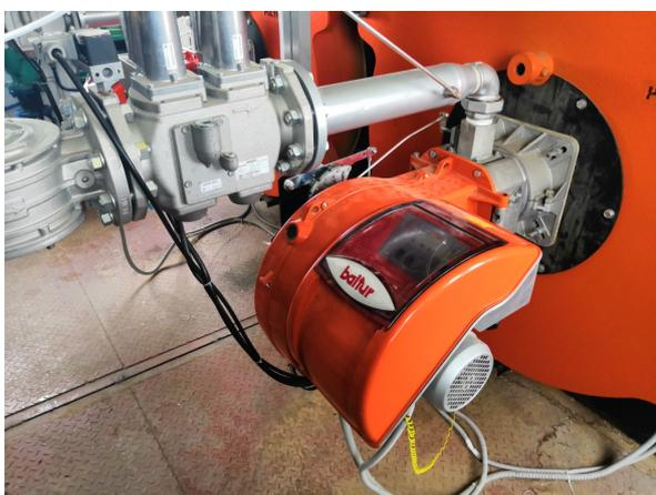
**Рис. 9.2 Общий вид горелки ТВГ 210Р**
