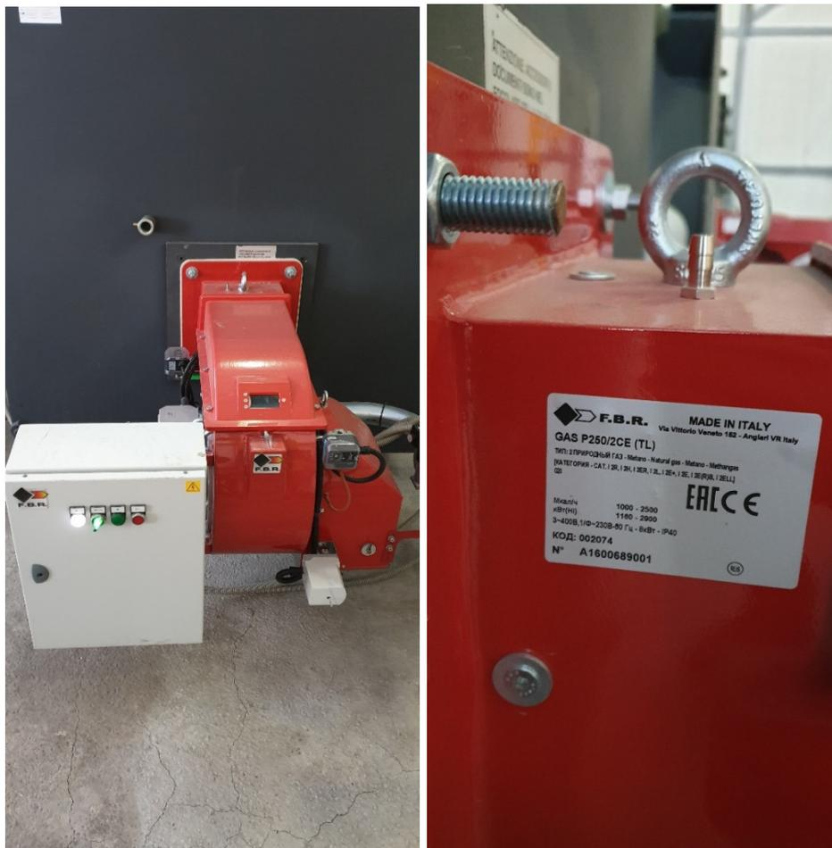
Рис. 21.3 Общий вид горелки К 250/2CE (TL)
