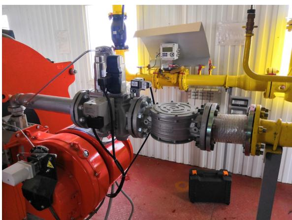
**Рис. 8.2 Общий вид горелки ТВГ 210Р**
