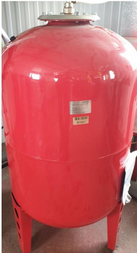
Рис. 3.4 Мембранный бак системы отопления
