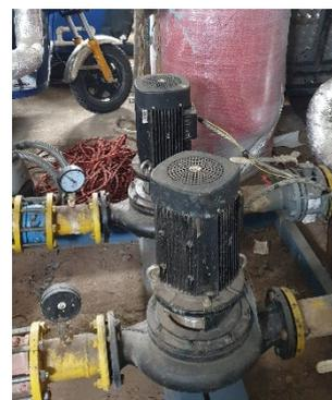
**Рис. 24.4** Моноблочный центробежный насос ГВС №1, №2
