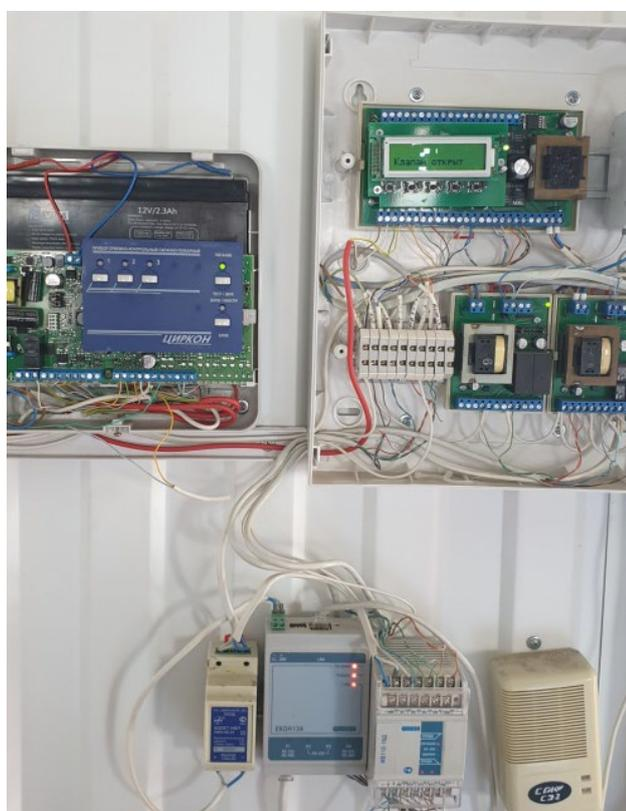
Рис. 16.5 Система защиты пожарной сигнализации
