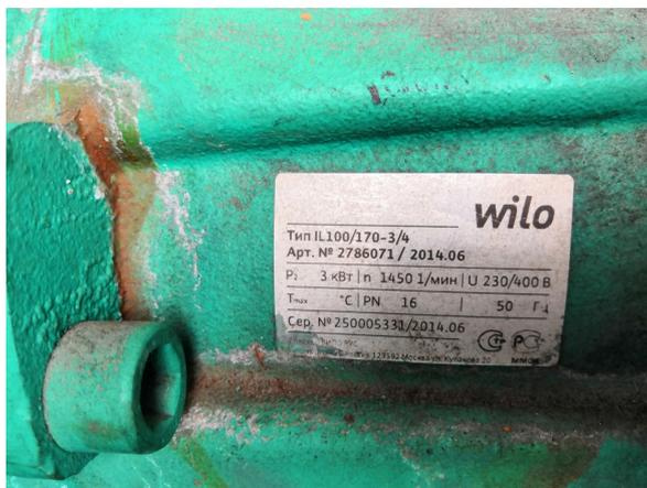
**Рис. 7.3** Насосное оборудование котельной
