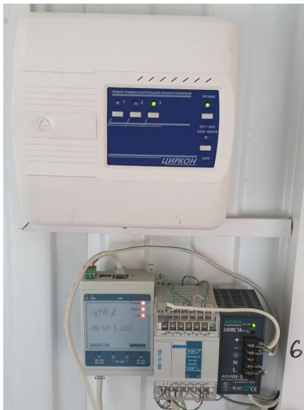
Рис. 17.5 Система защиты пожарной сигнализации
