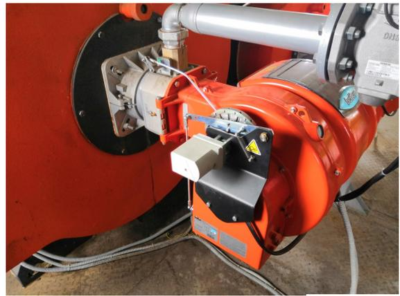
**Рис. 10.2 Общий вид горелки TBG 120P и TBG 210P**
