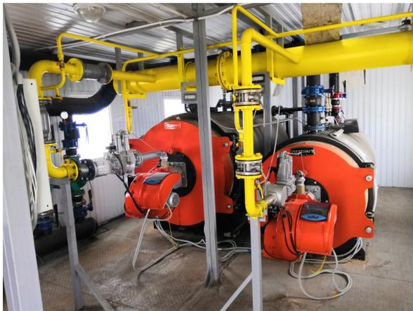
**Рис. 10.1 Общий вид котлов DUOTHERM 1000 и DUOTHERM 1500**
