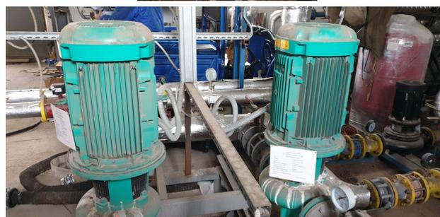
**Рис. 24.3** Моноблочный центробежный насос отопления №1, №2
