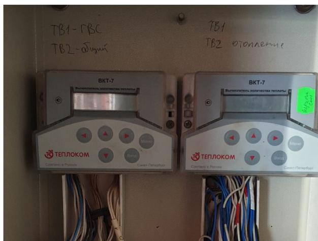
Рис. 23.4 Узел учёта тепловой энергии ГВС и отопления.
