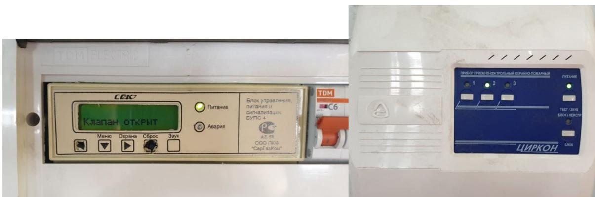
Рис. 5.9 Система защиты пожарной сигнализации
