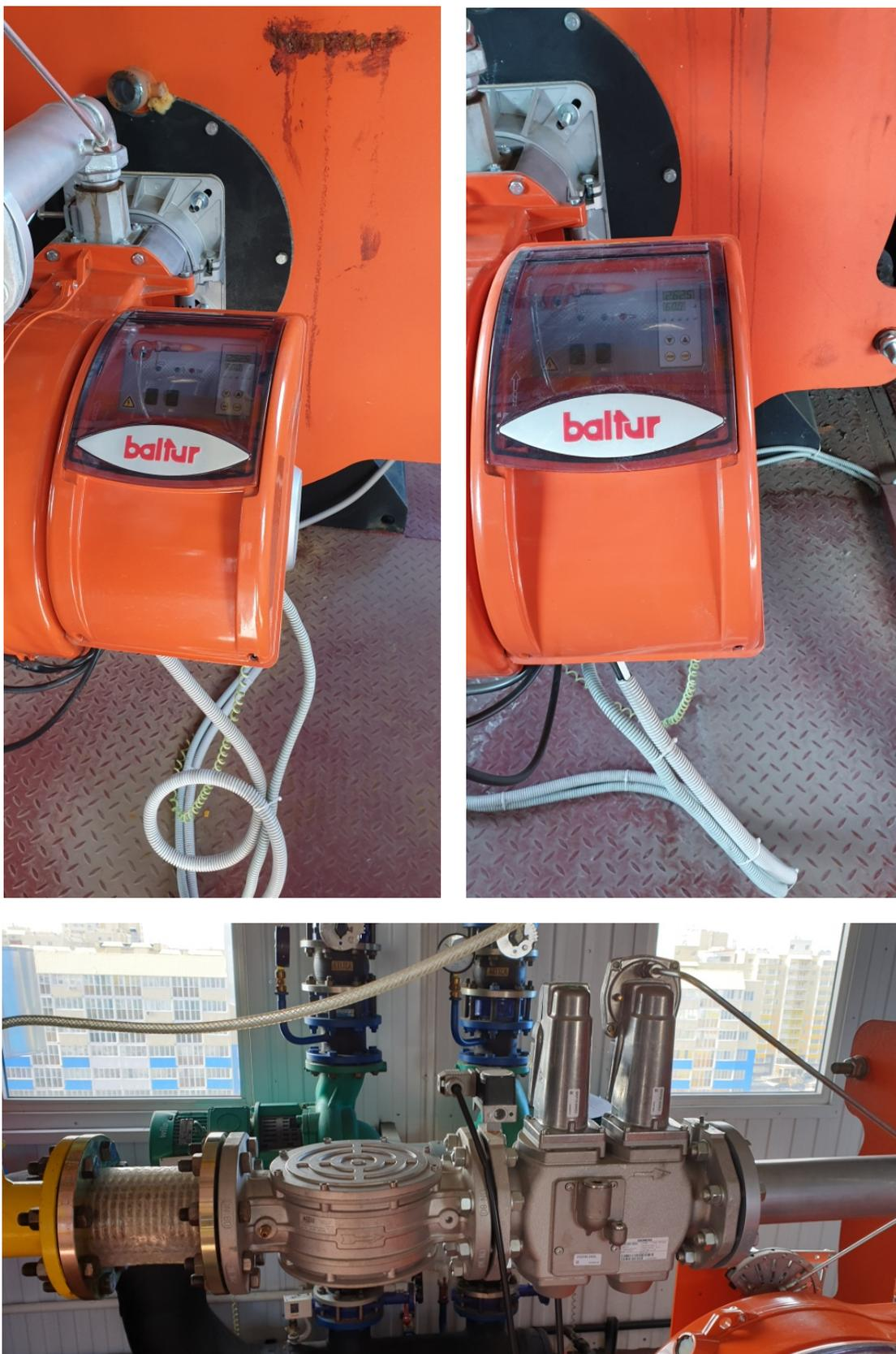
Рис. 15.2 Общий вид горелки ТВГ 210Р
