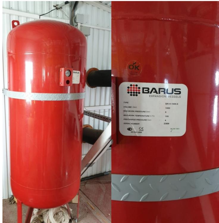
Рис. 4.4 Мембранный бак системы отопления
