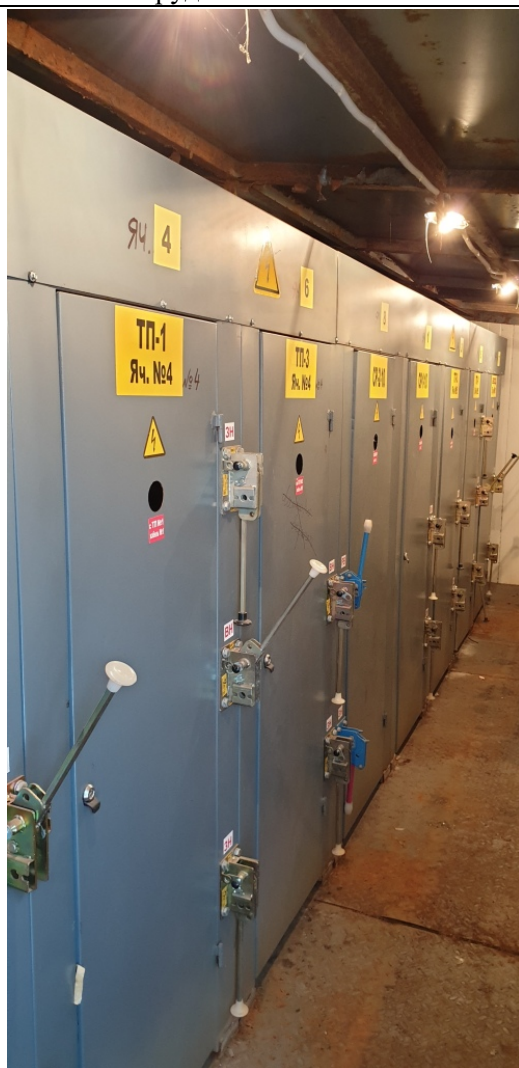
В РУ 10 кВ установлены камеры типа КСО серии 393 с ВНА-10
